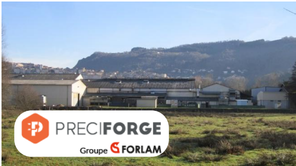
Usine de métallurgie à Thiers (63)
